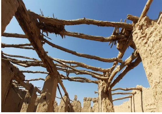
صورة توضح سقف بيت الصلاة
