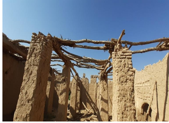
صورة توضح سقف بيت الصلاة
