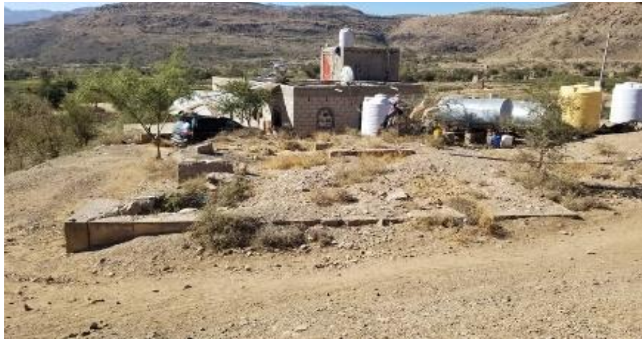
الشكل ١٨: الجدار الشرقي للمبنى أو المعبد، ويظهر خلفه منزل أحد المواطنين (الصورة باتجاه الغرب).
