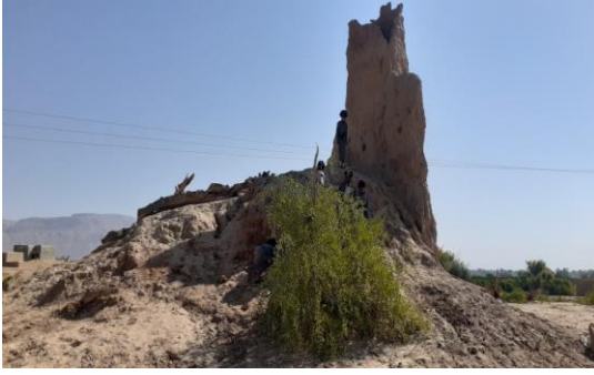
صورة توضح مدخنة المحرق
